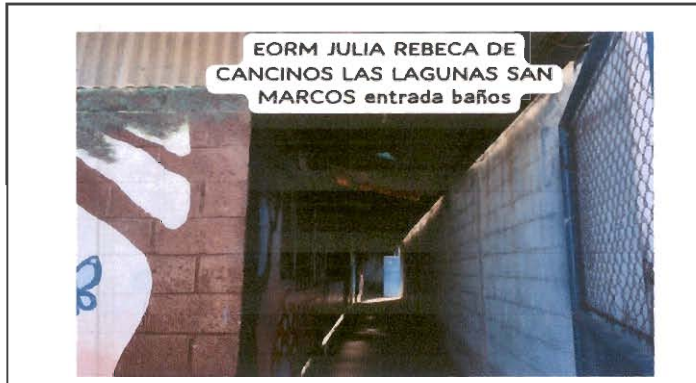
Foto1: Entrada para los baños
